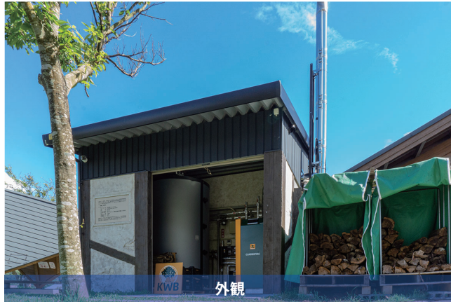
KWB 社製バイオマスボイラー 28.6kW
